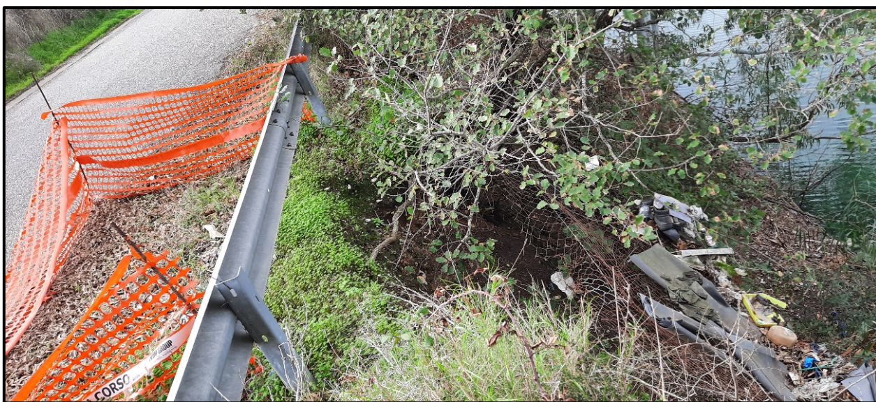
Cedimento della sponda del lago di cava
